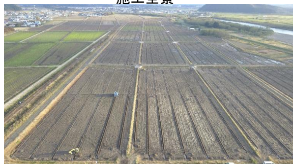
令和元年度北秋田管内:大館市上川沿地区
